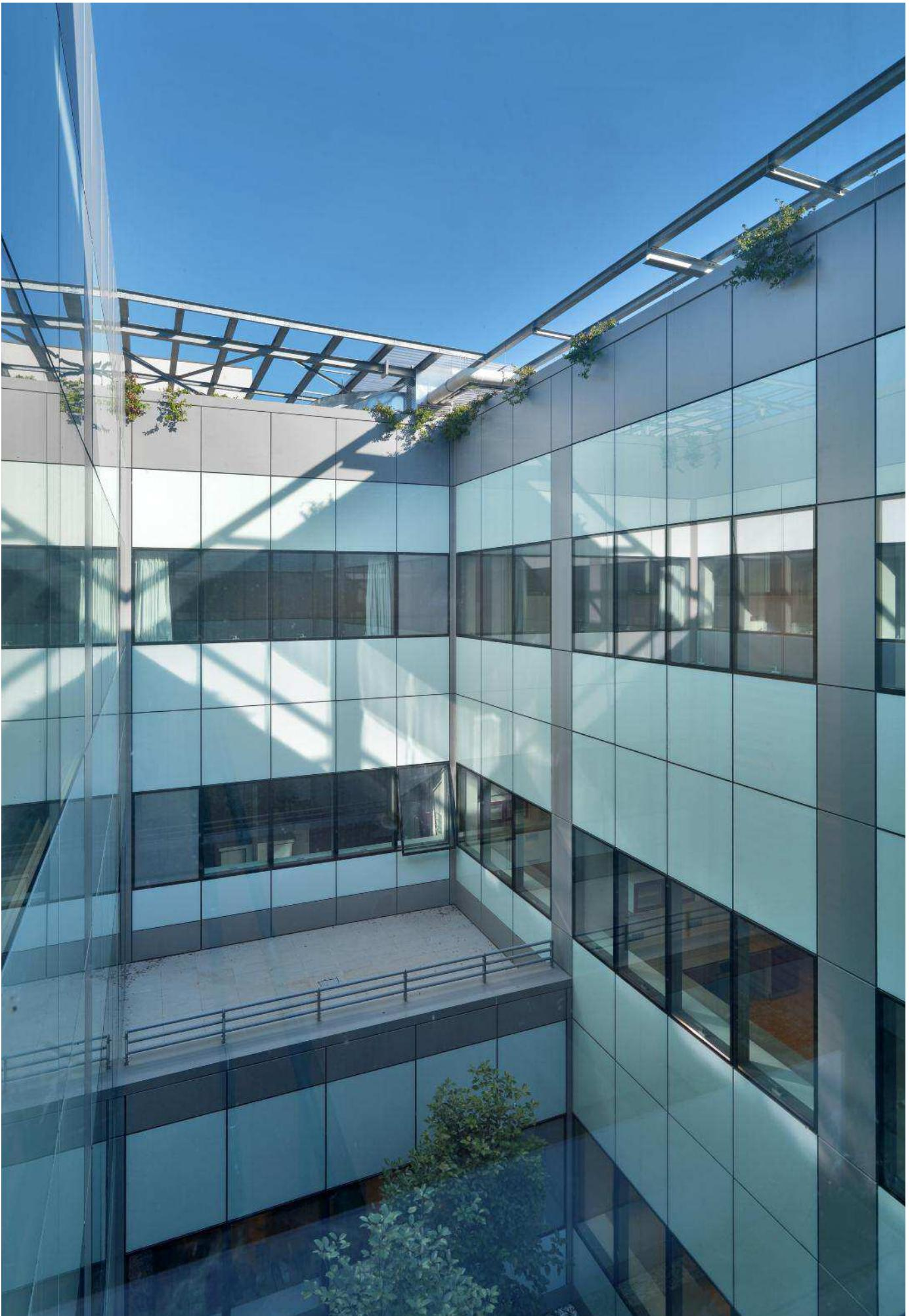
permettendo un recupero di circa 25 mq a piano rispetto alla soluzione tradizionale. **La prefabbricazione degli elementi in acciaio e degli elementi di solaio ha permesso inoltre un abbattimento dei tempi di costruzione in cantiere del 25% rispetto ad altre tecniche costruttive.**
