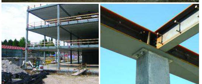
**SFB costituite da profili H ai quali sono saldati, sotto l'ala inferiore, piatti sporgenti a sbalzo che sostengono i pannelli di solaio in fase di costruzione.** I profilati sono dotati di connettori a piolo, saldati sull'anima, che hanno il doppio scopo sia di contrastare lo scorrimento tra l'acciaio strutturale e il calcestruzzo di completamento gettato in opera sia di impedire fenomeni di instabilità delle lastre che rivestono l'anima. Gli elementi verticali
